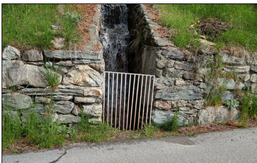
Foto 36 – Sezione T-T - Q_{\max(90\%)}=3.69 \text{ m}^3/\text{s}
