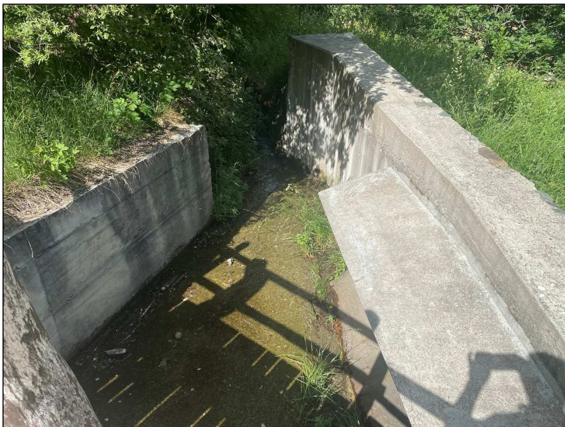
Figura 11. Zona di espansione prima della confluenza nel canale regolarizzato che bypassa il villaggio
