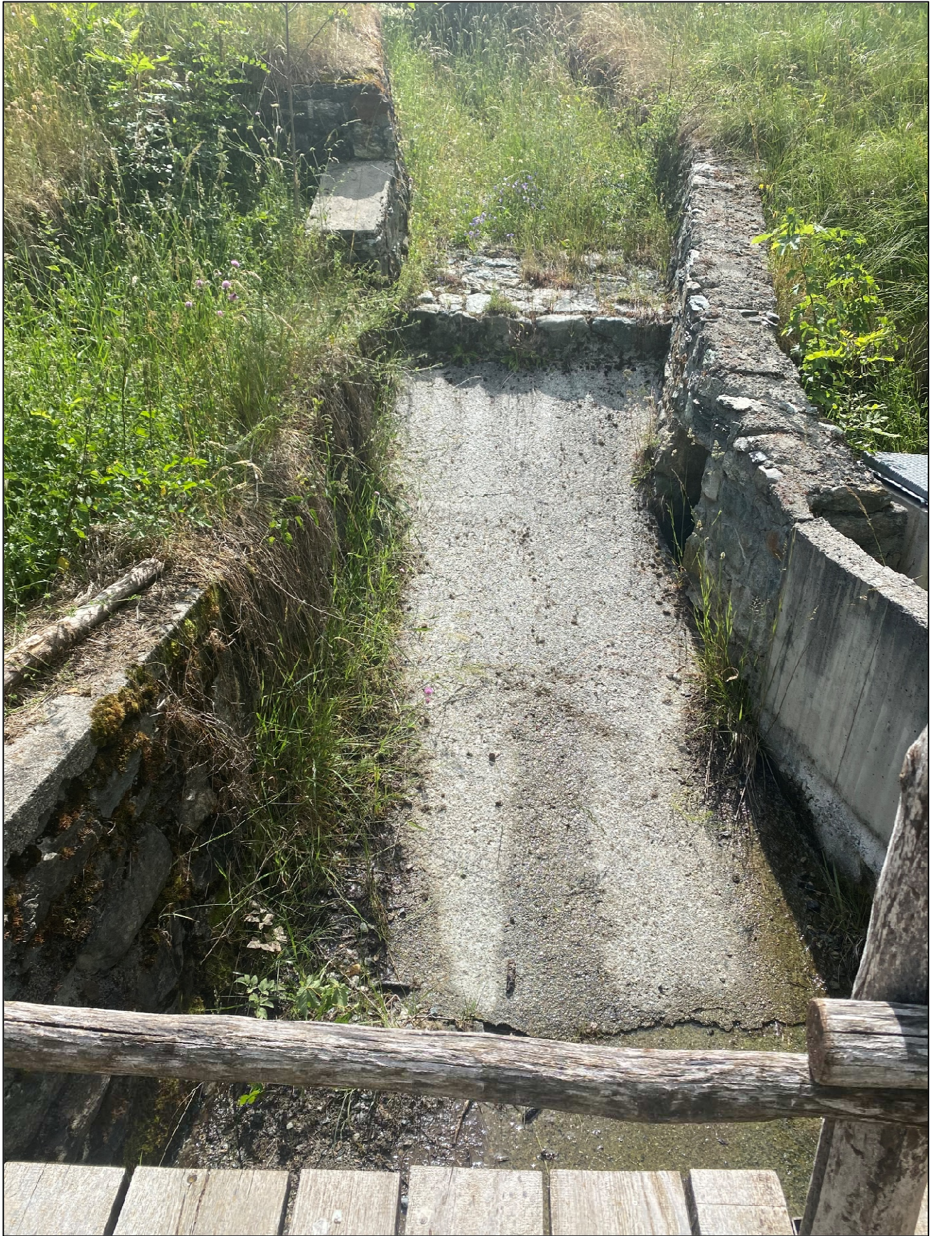
Figura 10. Settore di canale regolarizzato a monte della frazione Verney che si raccorda con l'alveo naturale
