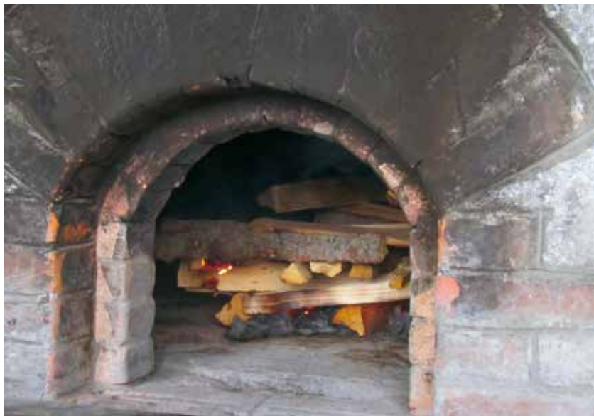
LE-S-ETELLE SCALDANO LA VOLTA DEL FORNO (FOTO P. MINETTI)
