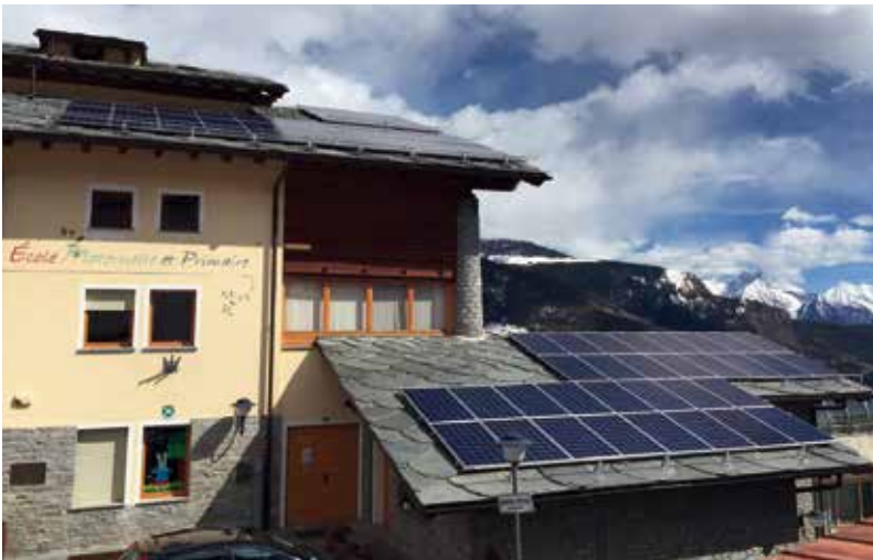
I PANNELLI SOLARI POSIZIONATI SUL TETTO DELLA SCUOLA (FOTO J. REY)
