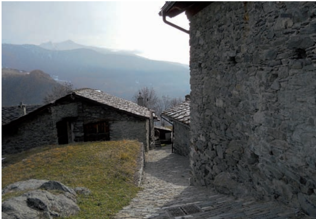
SCORCIO DEI LAVORI DI SISTEMAZIONE DELLA FAZIONE TRIATEL (FOTO L. PERRIN)
